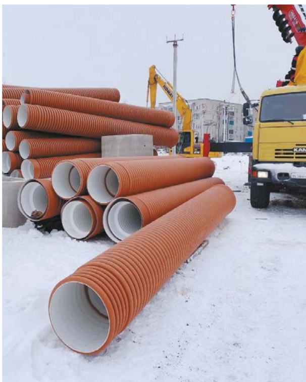
Объект: Складской терминал, г. Липецк. Подрядчик: ООО «Сантех Элстрой».
