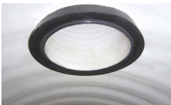
4. Вид изнутри трубы после монтажа.
