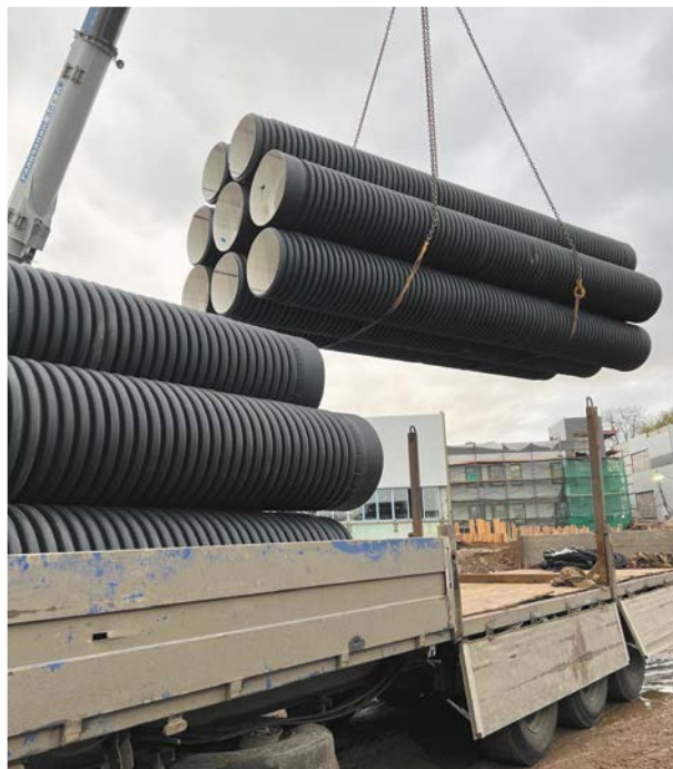
Объект: Мосводосток, г. Москва ул. Верейская. Подрядчик: Компания «МГрупп».
