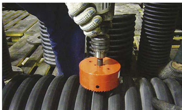
1. В шахте колодца вырезать отверстие с помощью фрезы.
