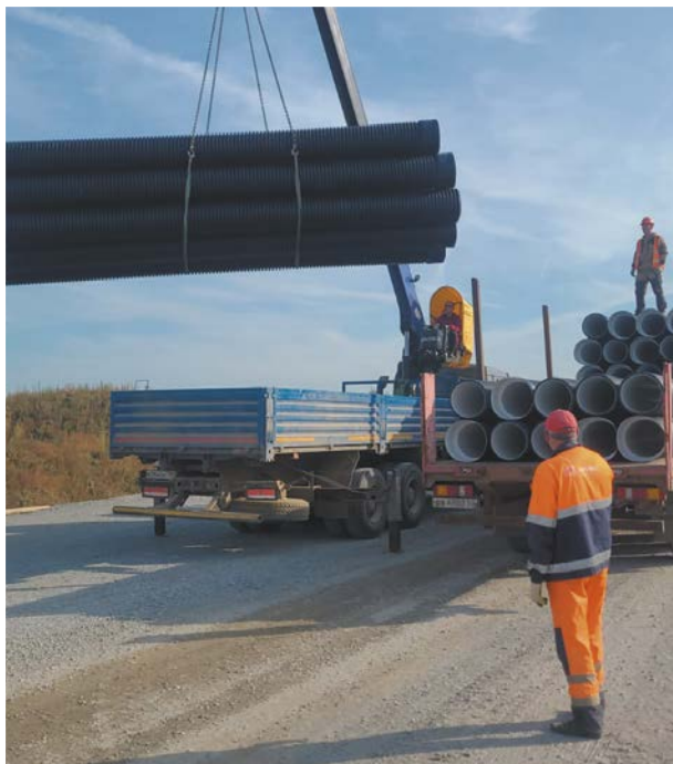
Объект: ЦКАД, Московская область. Подрядчик: Компания «АКС».
